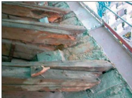
Schadhafte Auflager, Decke Dachstuhl Südseite
