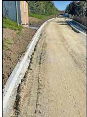
Der Ausbau der Schloßstraße macht große Fortschritte. Derzeit werden die Bordsteine sowie Sinkkästen gesetzt. Im Zuge der Sanierung wurde das Wasserleitungsnetz überprüft und die Wasserschieber erneuert, eine neue Erdgasleitung wurde verlegt wie auch neue Hausanschlüsse. Die Gemeindeverwaltung bedankt sich bei den Anliegern für das Verständnis über die notwendigen Einschränkungen während der Bauzeit. In absehbarer Zeit wird die Straße fertiggestellt und ist wieder frei befahrbar.
